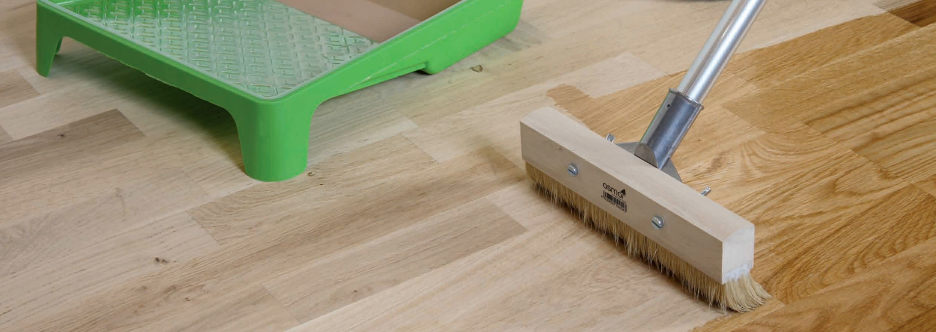
Osmo Keményviasz Olaj felhordása Osmo padlókefével
