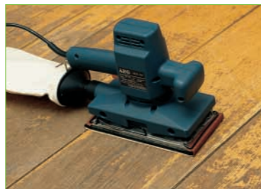
A padló felújításához a lakkozott felületet először le kell csiszolni.
